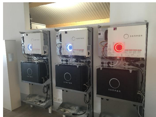
Speicherblock bei der Installation
