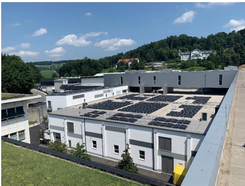
Bild ABEL ReTec: 481 kWp Anlage in Ost-West-Ausrichtung
